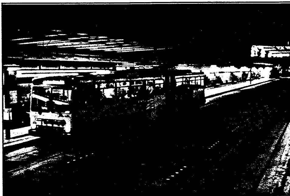
Bild 7.16 Tunnel avsedd för trådbussar och förberedd för Light-Rail.
