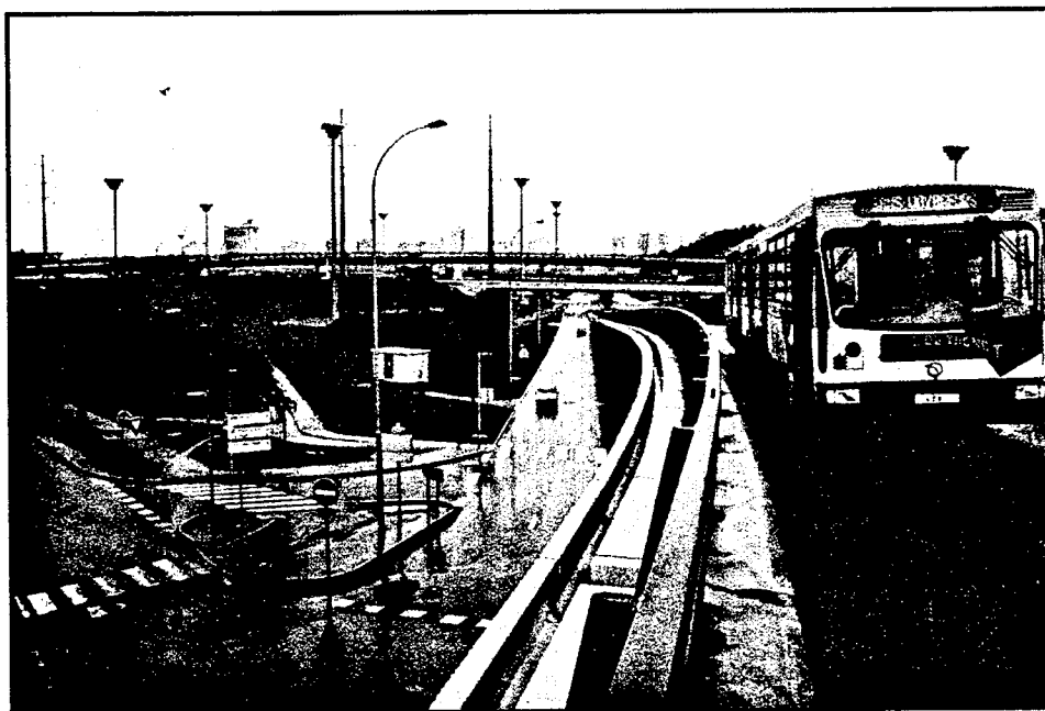
Bild 7.7 Bussbana byggd på bro över cirkulationsplats. Denna åtgärd sparar mellan 5 och 10 minuter i högtrafik för bussarna.
