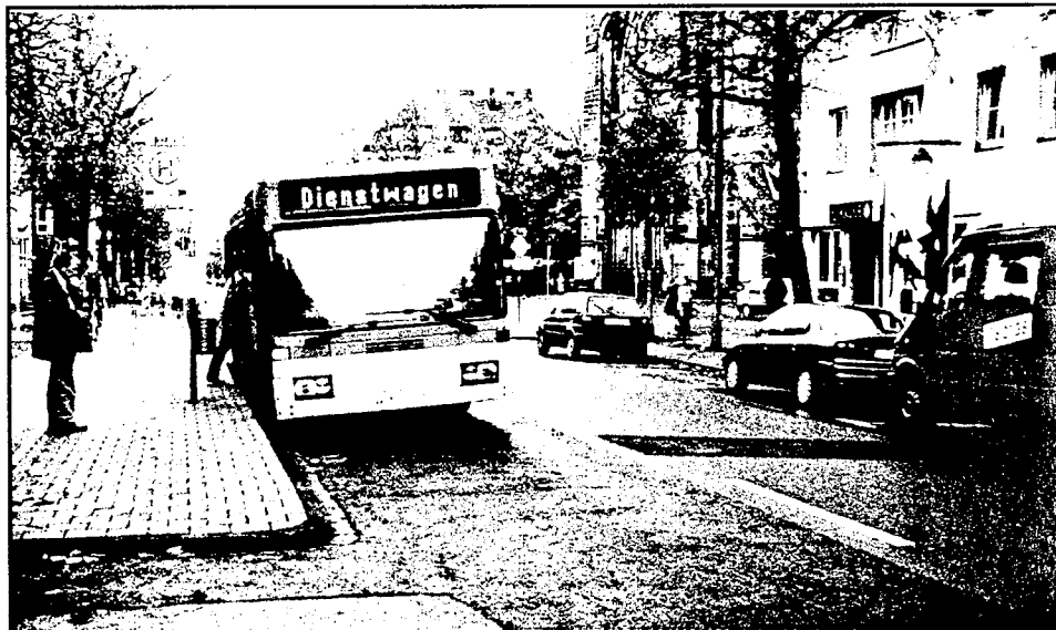
Figur 2.5 Exempel på rak hållplats i Münster, Tyskland.
