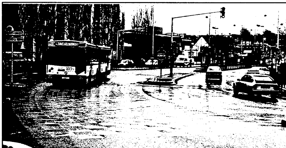
Figur 3.1 Exempel från Frankrike på markering med vita rutor på kollektivkörfält i korsning (TVM i Paris).
