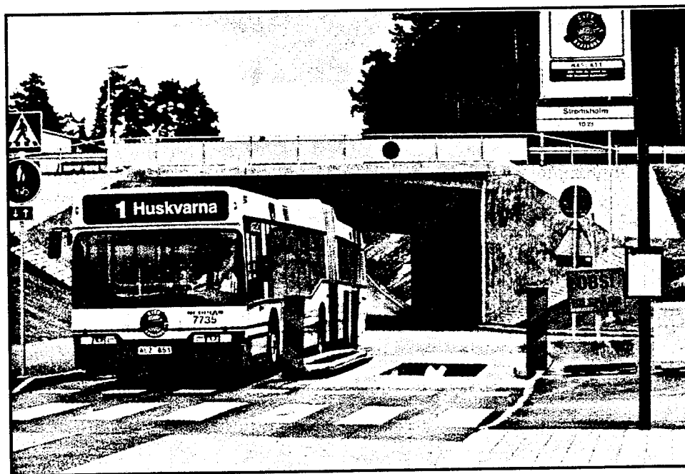
Bild 7.4 CityBuss i Jönköping på linje 1 passerar ett spårviddshinder. I bakgrunden syns den nya planskildheten med riksväg 40.
