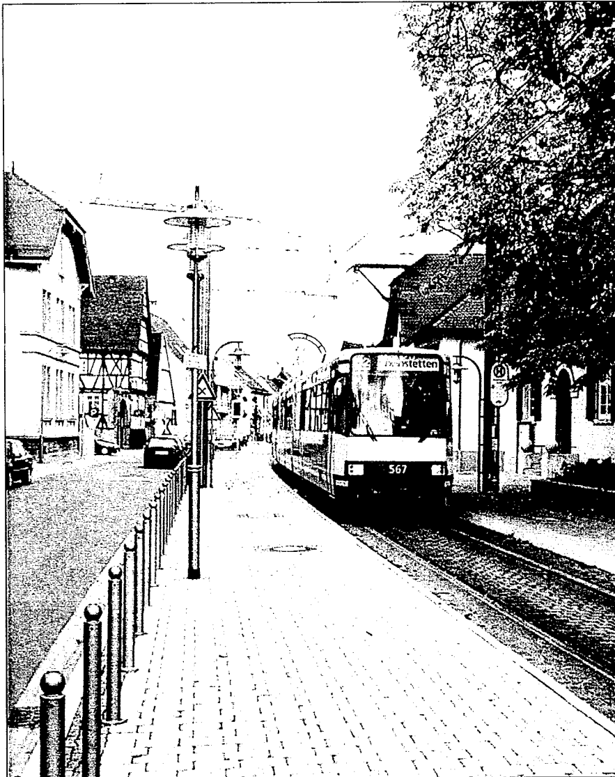
Figur 10.2 Exempel på ytbeläggning i spårområdet.
